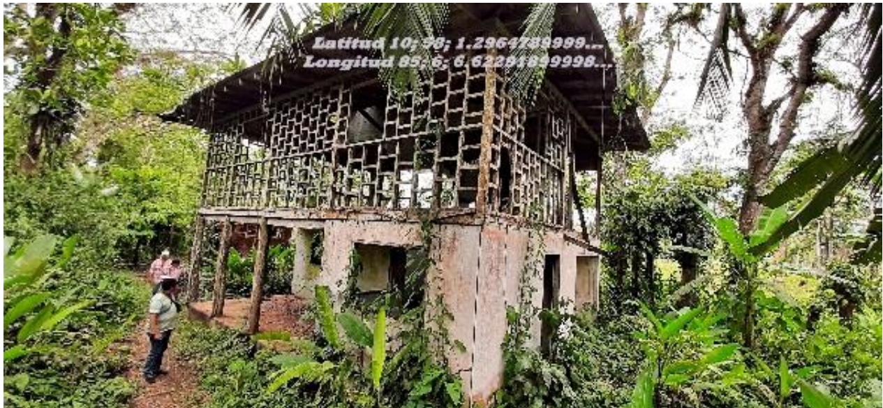
Descripción: Antigua casona del SINAC dentro del Refugio.
